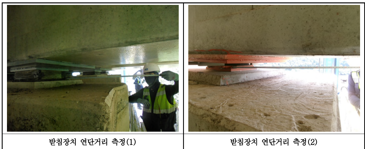
【사진 10.3.37】 교량받침장치 연단거리측정
