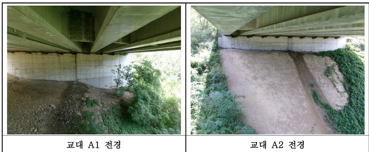
【사진 10.3.8】 교대 전경
