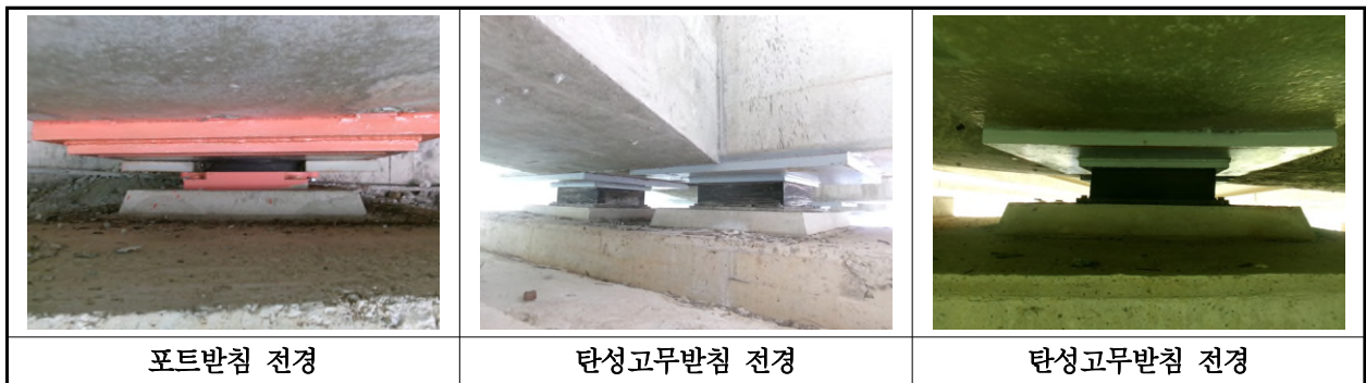
【사진 10.3.12】 교량반침 전경
