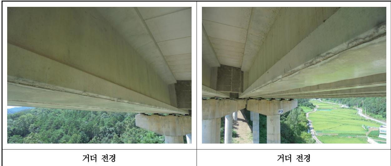
【사진 10.3.27】 거더 전경
