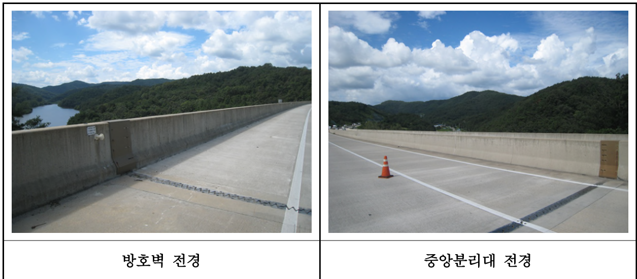
【사진 10.3.46】 방호벽 및 중앙분리대 전경
