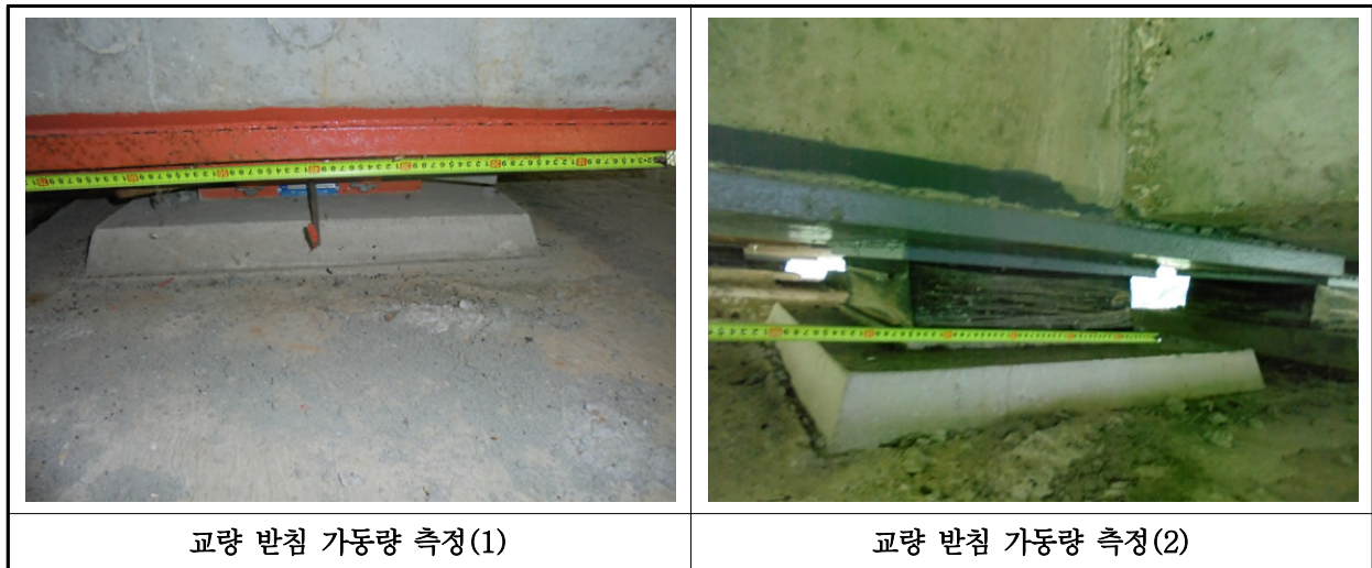
【사진 10.3.38】 교량받침 이동량 측정
