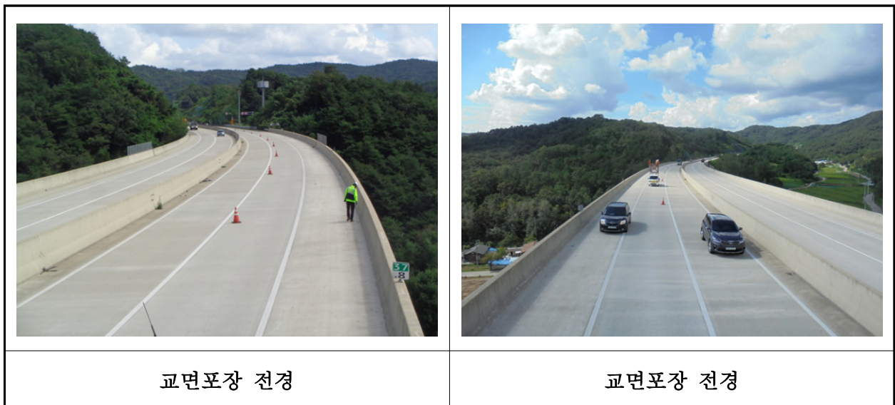
【사진 10.3.42】 교면포장 전경
