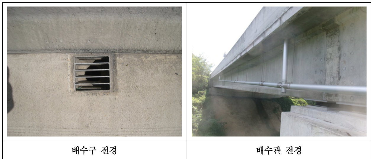
【사진 10.3.21】 배수시설 전경
