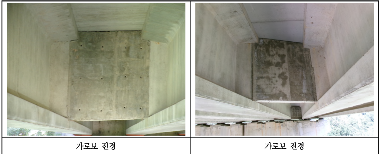
【사진 10.3.6】 가로보 전경
