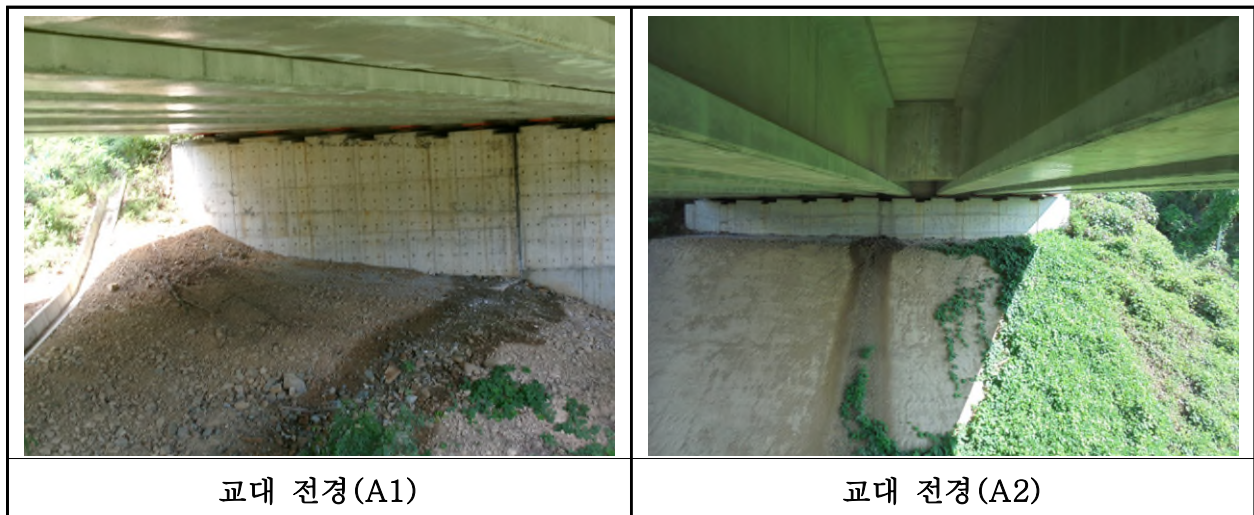
【사진 10.3.31】 교대 전경
