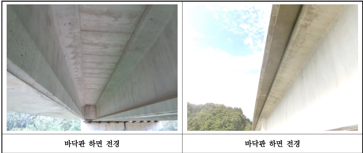
【사진 10.3.25】 바닥판하면 전경
