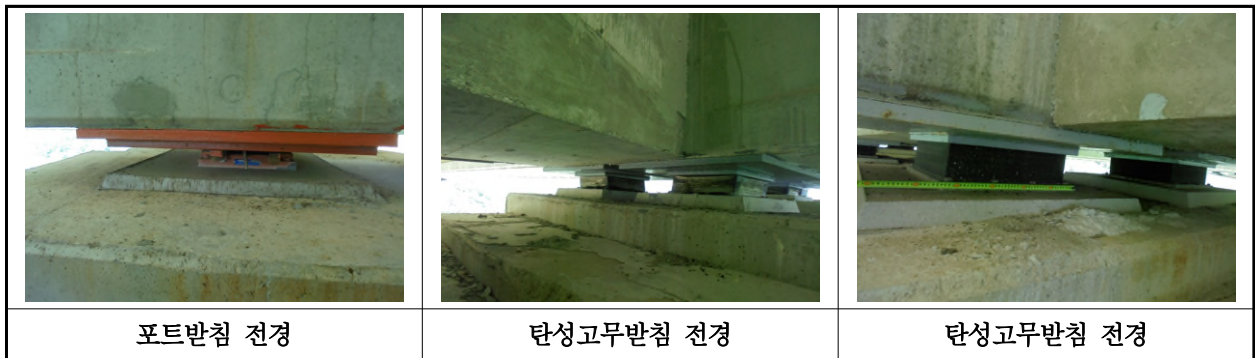
【사진 10.3.35】 교량받침 전경
