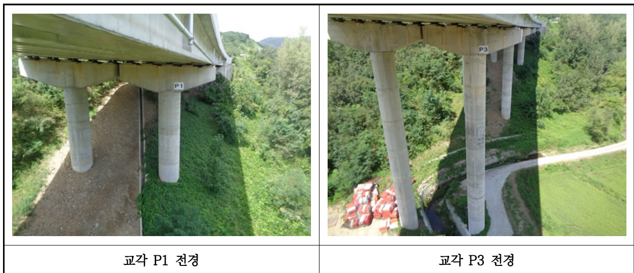
【사진 10.3.10】 교각 전경
