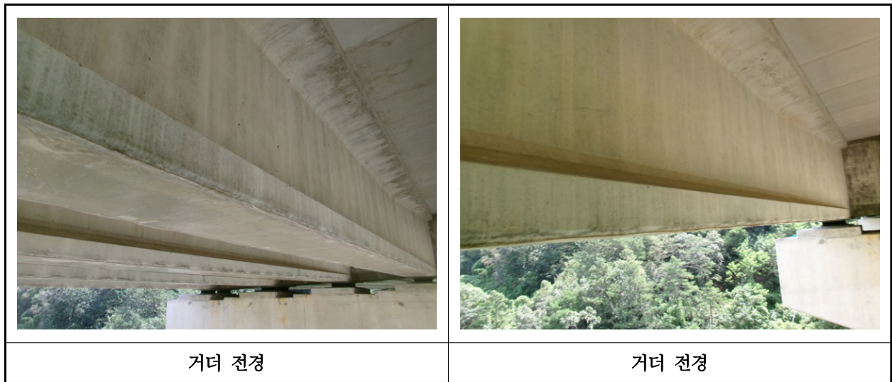
【사진 10.3.4】 거더 전경
