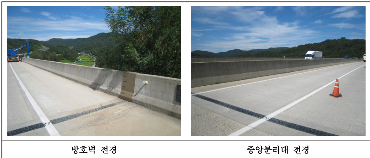
【사진 10.3.23】 방호벽 및 중앙분리대 전경
