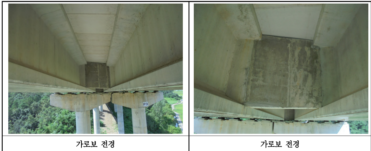
【사진 10.3.29】 가로보 전경
