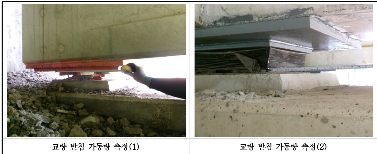
【사진 10.3.15】 교량받침 이동량 측정
