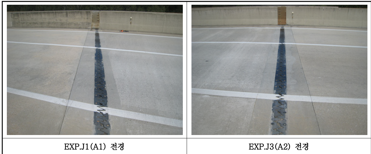
【사진 10.3.39】 신축이음장치 전경
